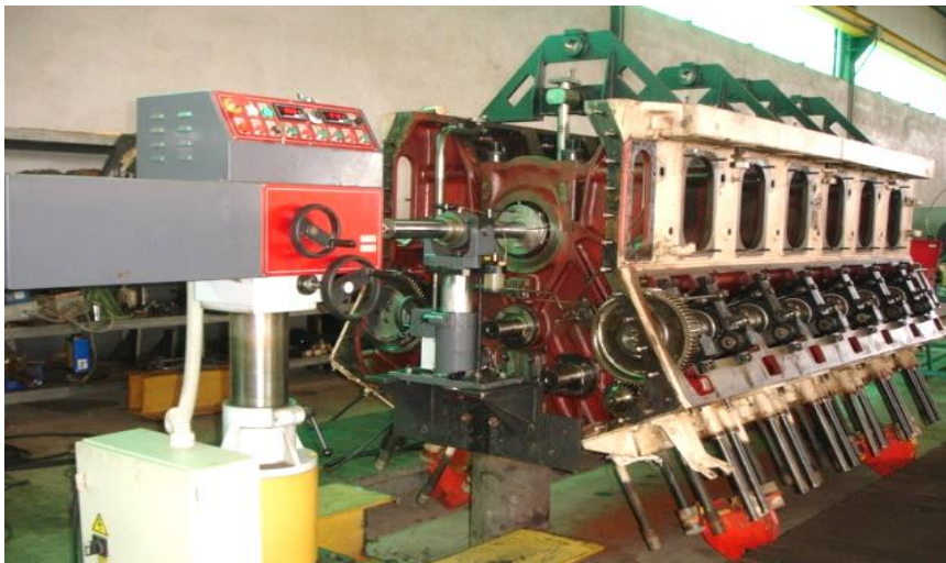
Alineación con Sistema Laser, Barrenado de Bloque, Reparación y Fabricación de insertos de Bloque. Prueba Hidrostática,
